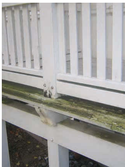
Alten Belag entfernen
