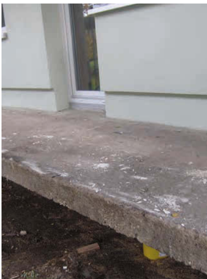
Brüstung und Belag entfernt
