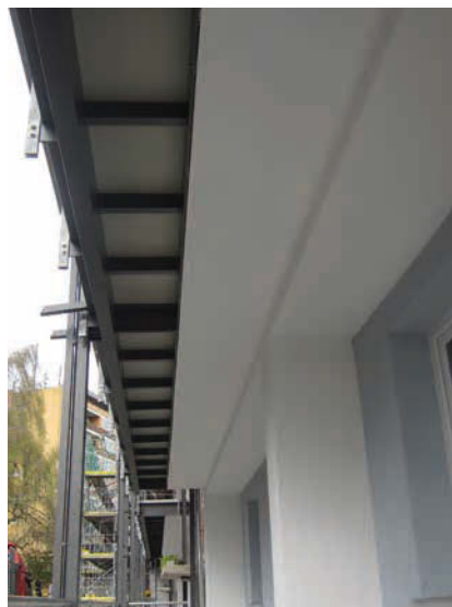
Erweiterung der Balkonfläche
