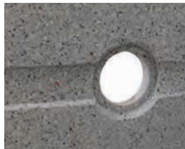
Fräsung für Abfluss Ø 50 mm und Ø 70 mm
