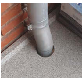
Lochbohrung Zur Durchführung von Fallrohren, Stützen etc.
