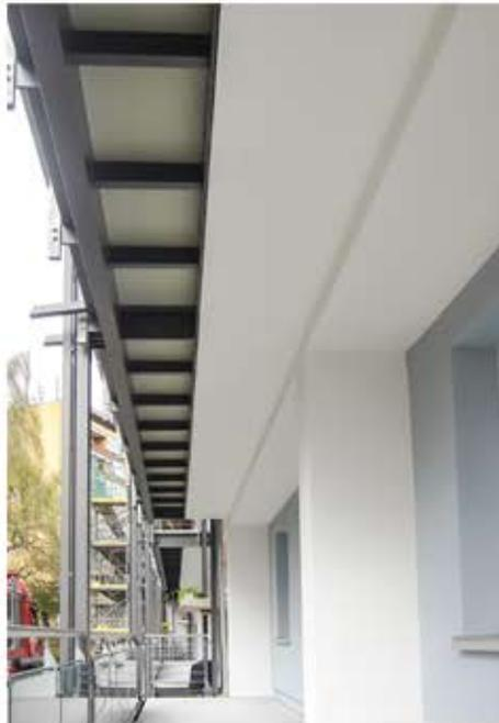
Hier wurde nicht nur der Belag mit **BALKOPLAN®** erneuert sondern auch gleich mittels einer Stahlkonstruktion erweitert.
